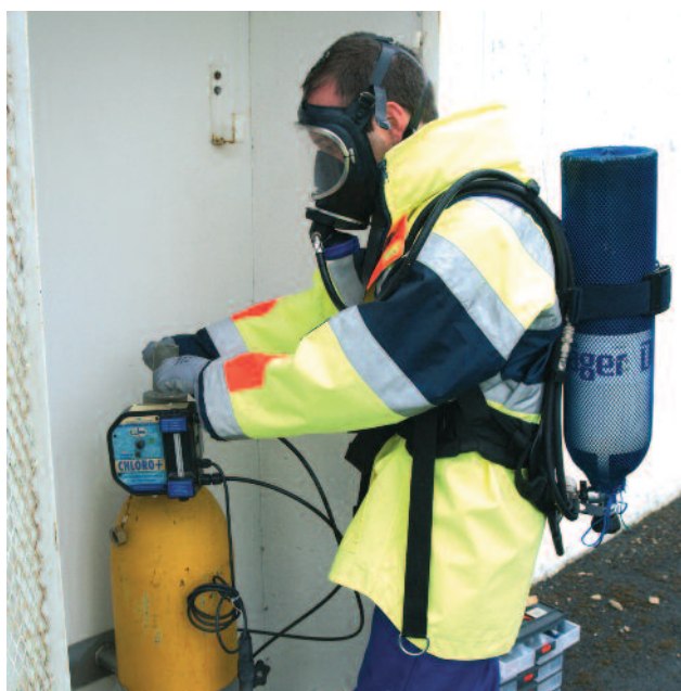
Intervention sécurité chlore
