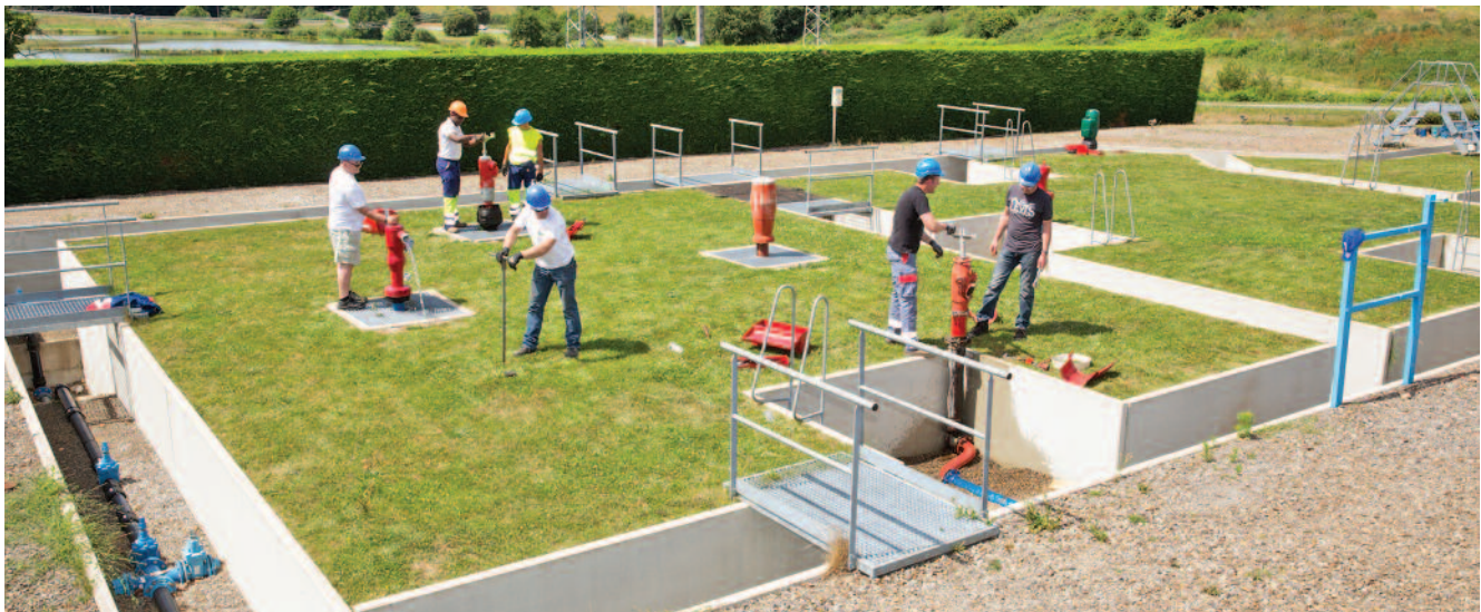
Plate-forme d'entraînement à la pose de canalisations d'eau potable
