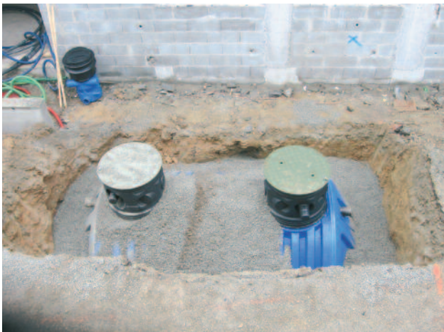
Pose de cuve de récupération d'eau de pluie
