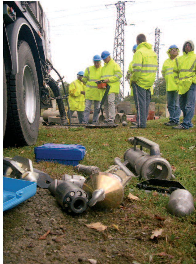
Travaux pratiques d'hydrocurage
