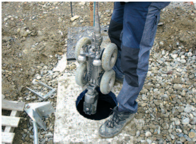
Inspection télévisée sur réseau d'entraînement
