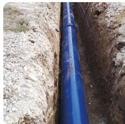
**Canalisations en alliage polymère pour l'adduction et la distribution d'eau et les réseaux d'irrigation. Le premier système d'alimentation en eau PVC-A (PVC-HI)\* certifié EPD® en Europe.**
