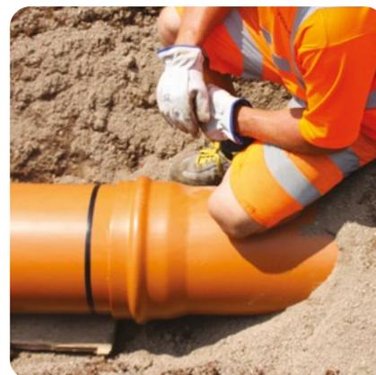
Le tube FITT Sewer EVO conforme à la norme UNI EN 1401-1:2019 pour les eaux usées et les drains industriels sans pression garantit des performances supérieures grâce à son système de jonction unique avec joint intégré et inamovible.
